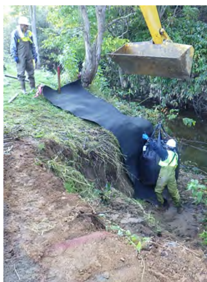
普通河川濁川河岸 修繕
