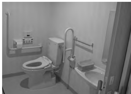
△トイレも各階に設置され、中も広くバリアフリーとなっています。
