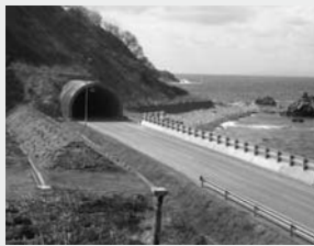
日屋部トンネル北檜山側
