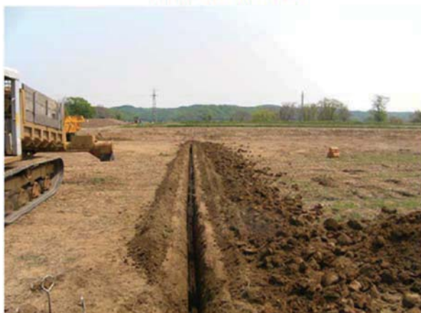
暗渠排水工施工状況
