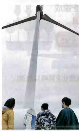
苫前町にある風力発電施設
