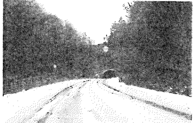
若松トンネル付近
