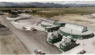
有限会社ドリームヒルのバイオガスプラント
