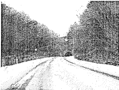
若松トンネル付近
