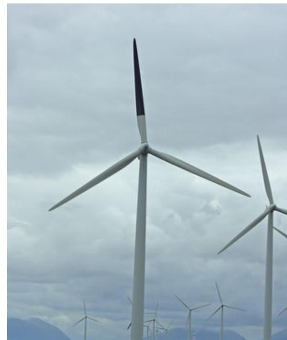
ノルウェーで行われたBACI法による調査：ブレードの一部が黒色に塗装されたタービンで鳥の年間死亡率が70%以上減少したと報告された(May et al, 2020).
