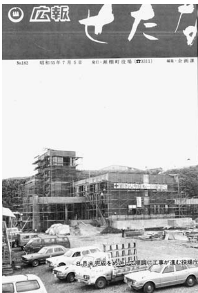
❏No.182 昭和55年、現在の役場庁舎の建設工場の写真です。
