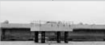
土台が完成。この上に風車を設置
