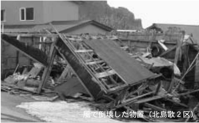
風で倒壊した物置（北島歌2区）
