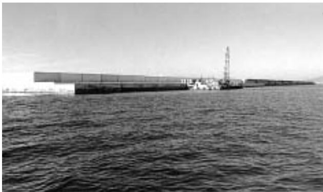
瀬棚港東外防波堤
