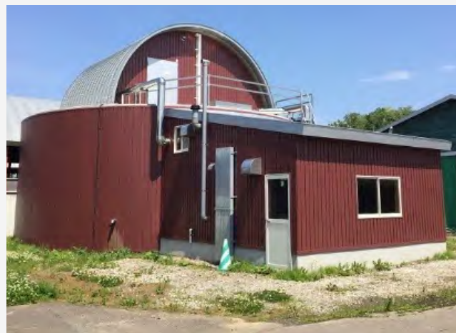
バイオガスプラント
