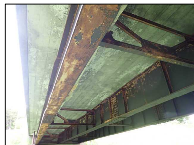
玉川橋(橋長20m) 昭和46年供用開始(52歳)
