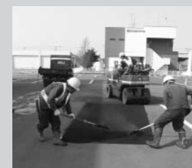
横駐車場の工事のようす
