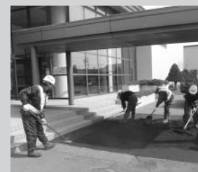
正面玄関入口の工事のようす
