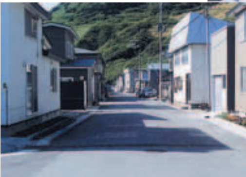
町並み整備が図られた太田地区集落
