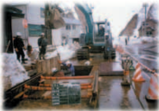
久遠地域における排水管渠の布設工事
