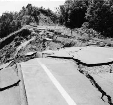
←崩落した道道小倉山・丹羽停車場線（北檜山）
