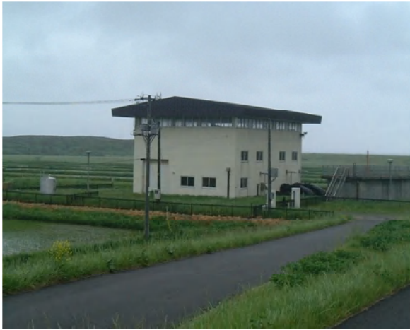
(西兜野排水機場)
