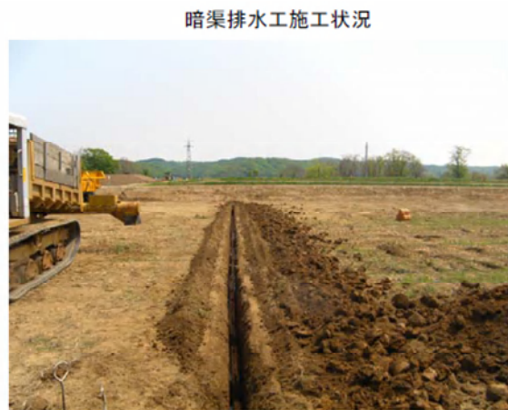
(水田の暗渠排水)
