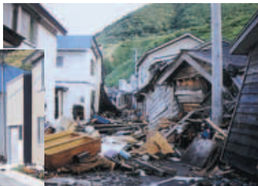
津波被害を受けた直後の状況
