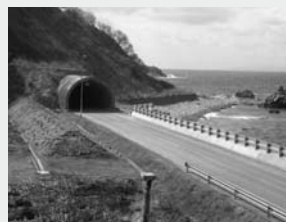
日屋部トンネル北檜山側
